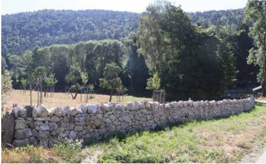
Les murs de pierres sèches font aussi partie des franges urbaines (photo pif).
